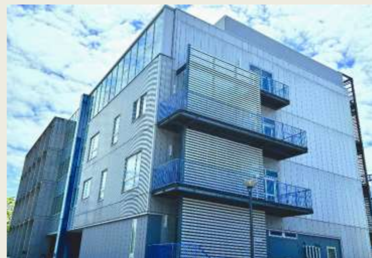
フロンティア研究棟
